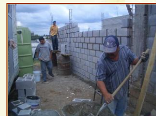
Costruendo una piccola ripostiglio
