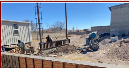
La construccion de la bodega avanza.
