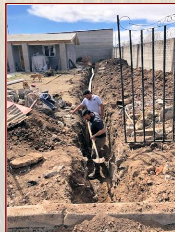
Una nueva linea para el drenaje a la base.
